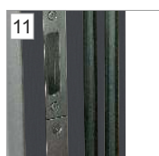
Przegroda termiczna, dwie uszczelki w ościeżnicy
